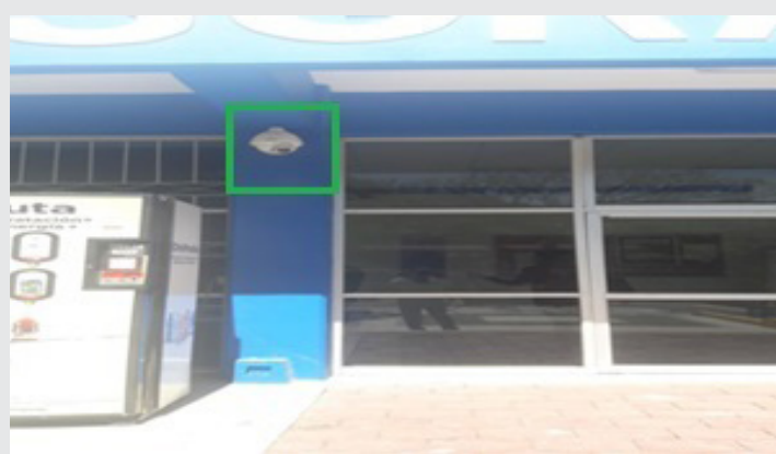
Figura 2. Ubicación de sensor en acceso principal. Fuente: Elaboración propia del autor.
